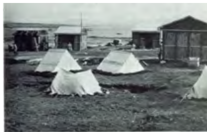
15. — Installation du premier camp de Port-aux-François. Vue prise en décembre 1949.
