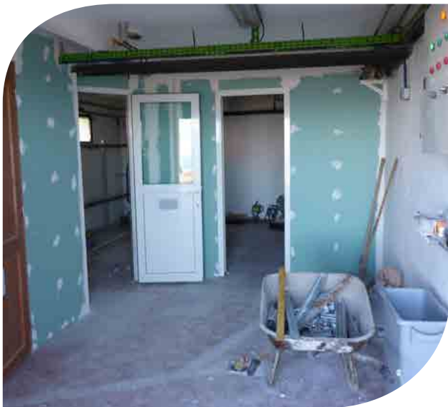
Le local en plein chantier en avril 2017.
