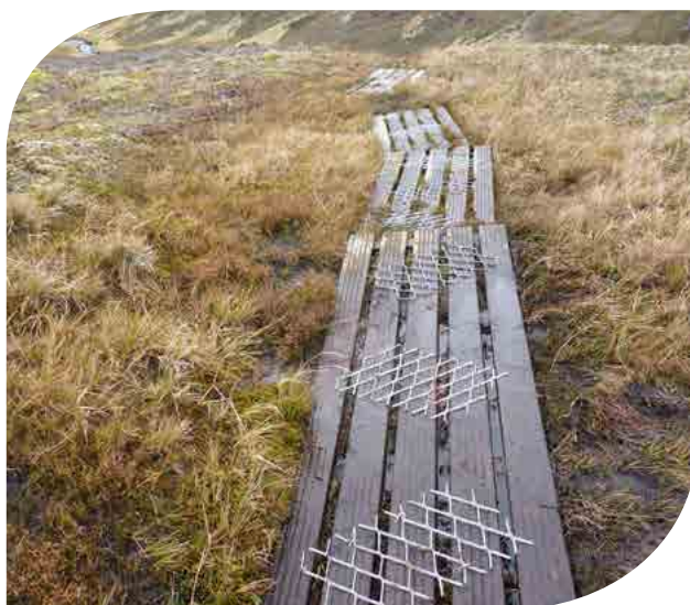
Caillebotis fraîchement aménagés de grilles antidérapantes à Crozet.
